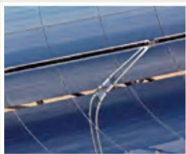
**3. TRANSFERENCIA DE LA ENERGÍA A UN FLUIDO TÉRMICO**
