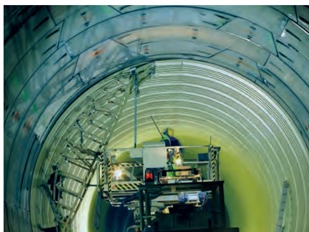
Las placas de composite se colocan sobre las dovelas de hormigón que forman el revestimiento del túnel y canalizan las filtraciones a los laterales.
