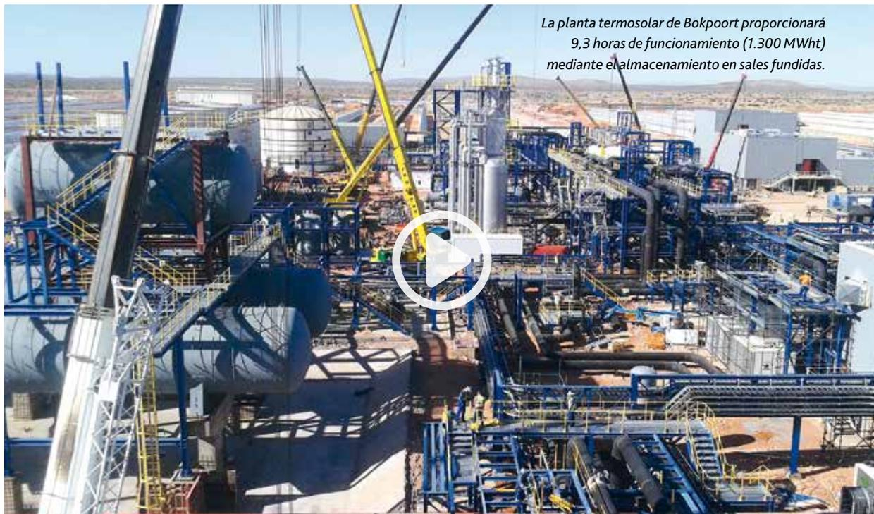
*La planta termosolar de Bokpoort proporcionará 9,3 horas de funcionamiento (1.300 MWh) mediante el almacenamiento en sales fundidas.*
