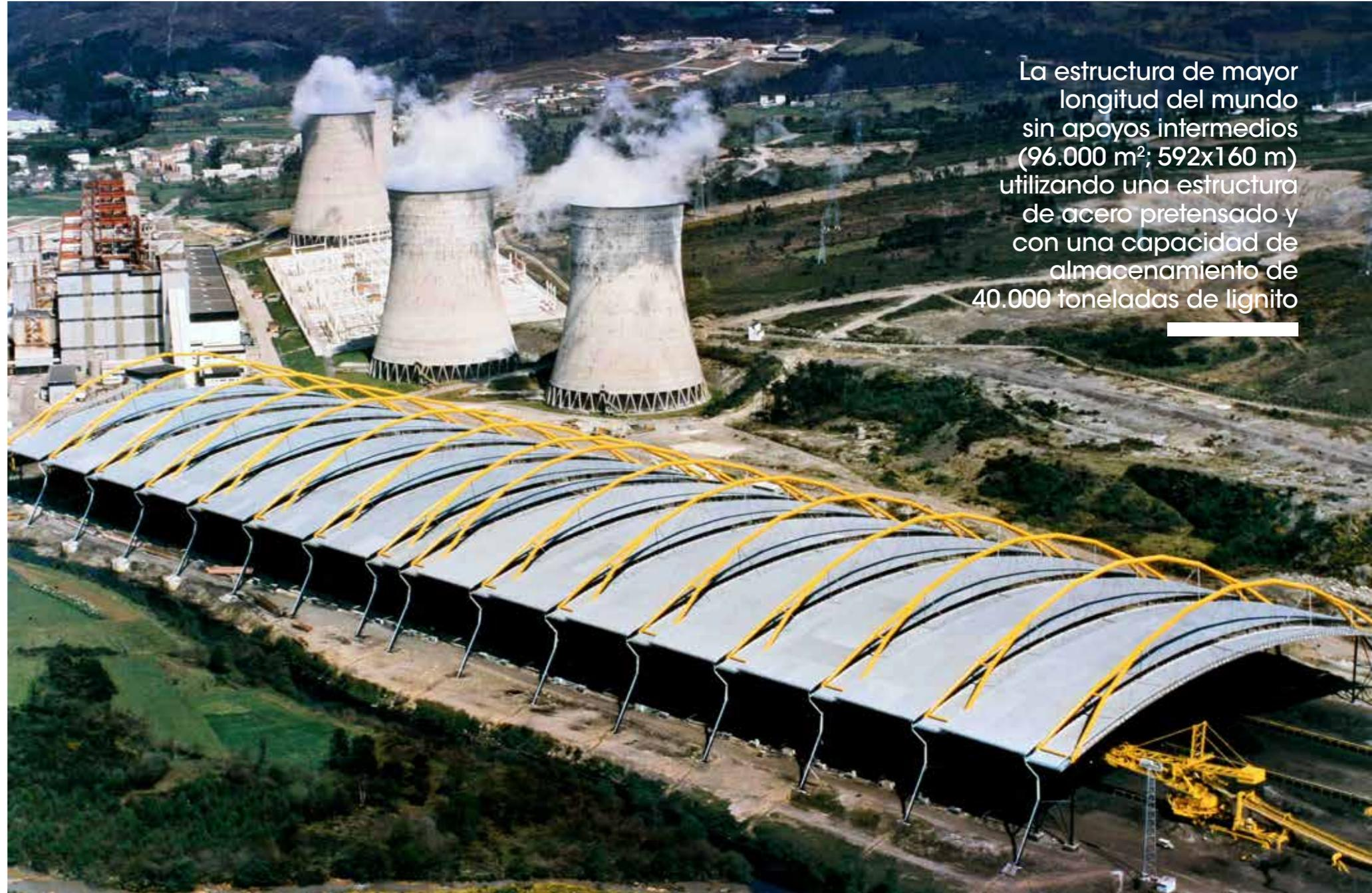
La estructura de mayor longitud del mundo sin apoyos intermedios (96.000 m<sup>2</sup>; 592x160 m) utilizando una estructura de acero pretensado y con una capacidad de almacenamiento de 40.000 toneladas de lignito
