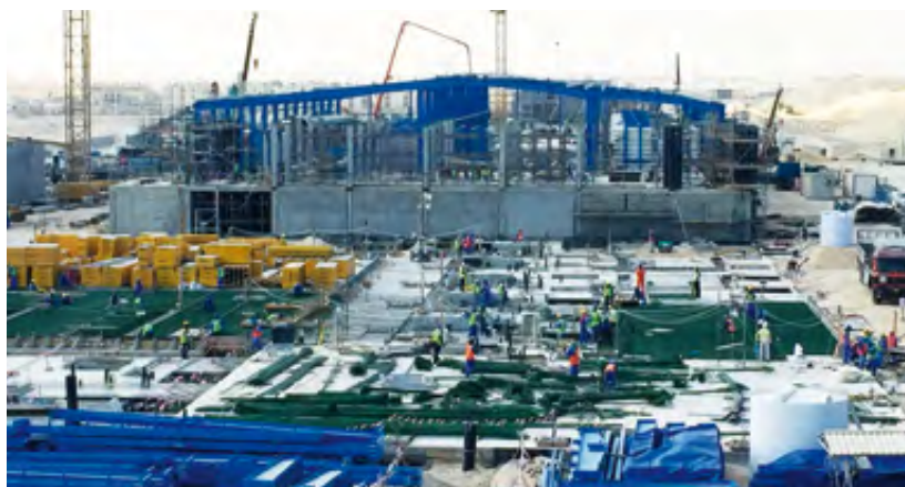
Planta Ras Abu Fontas A3 de Qatar, en construcción.
