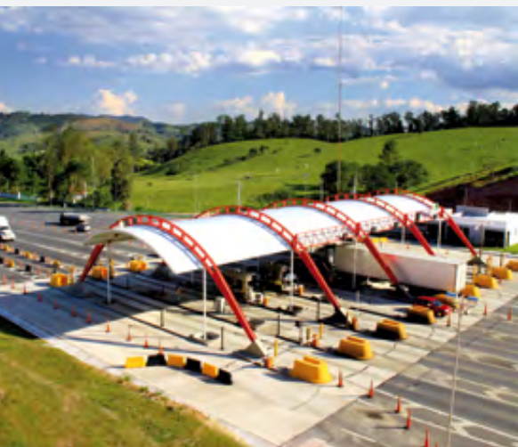
Autovía de peaje BR-393/RJ en Río de Janeiro. Plazo de concesión: 25 años.
