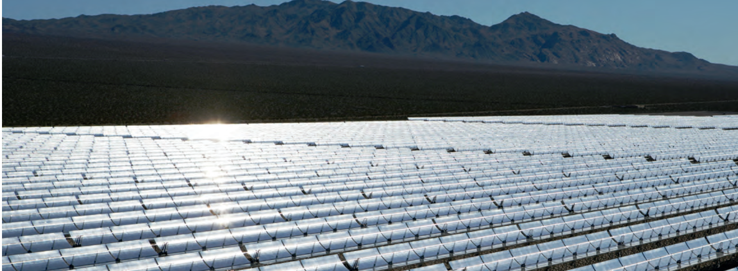
Planta termosolar Nevada Solar One (EE.UU.)
