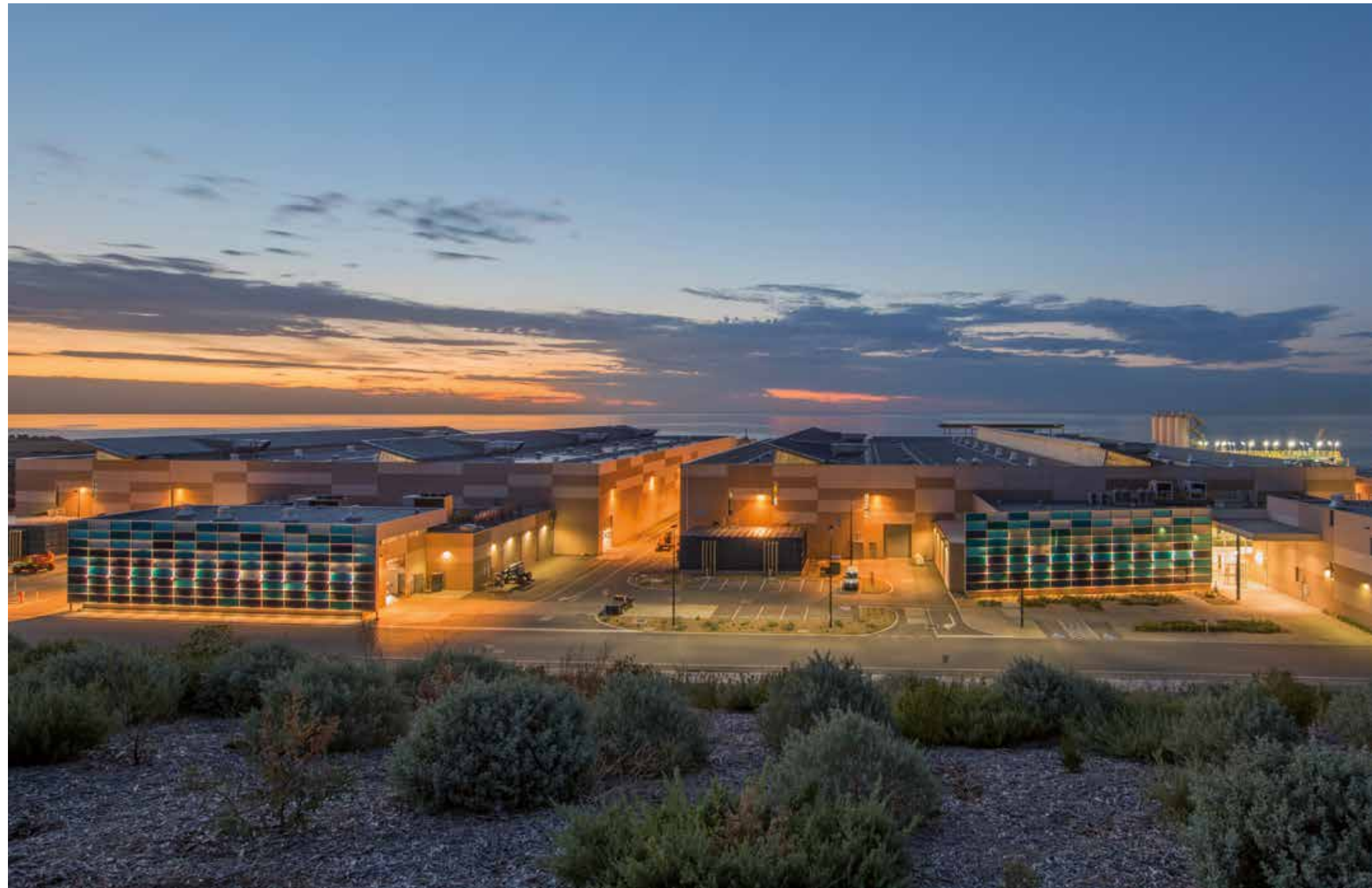
Planta desalinizadora de Adelaida, Australia
